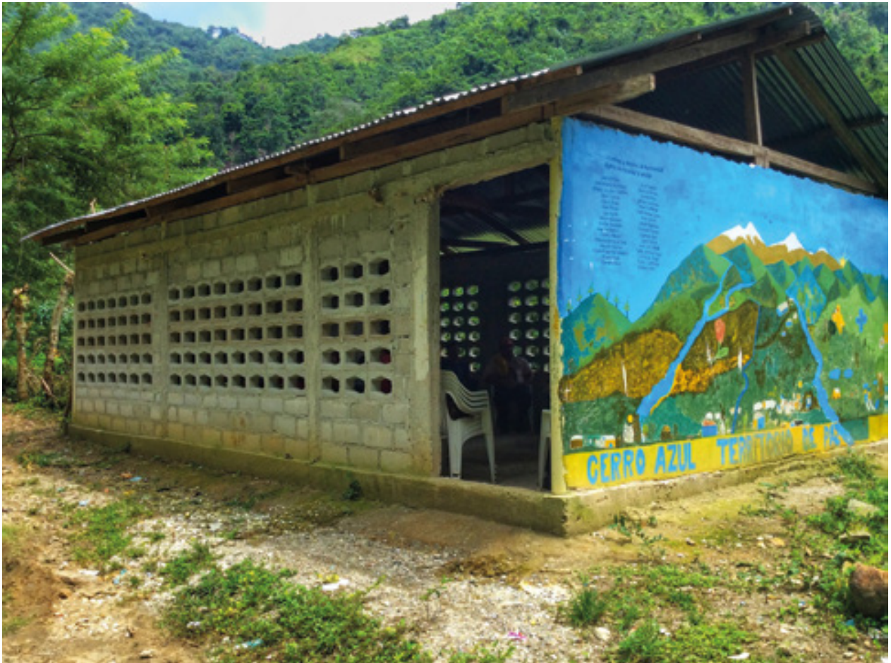
Quiosco comunal construido como medida de reparación dentro del Plan Integral de Reparación Colectiva. Fotografía: Carolina Restrepo para el CNMH.
