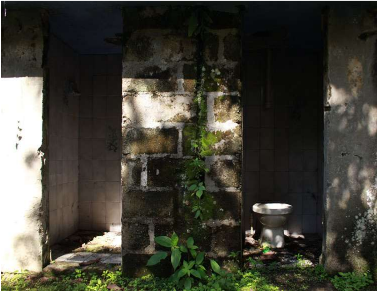
Restos de las viviendas afectadas tras la toma guerrillera del año 2000. Fotografías para el CNMH de Daniel Sarmiento Gómez, 2021.
