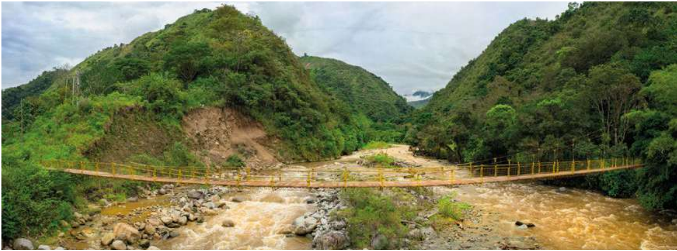
Puente Cambrín en la actualidad. Fotografía para el CNMH de Daniel Sarmiento Gómez, 2021.
