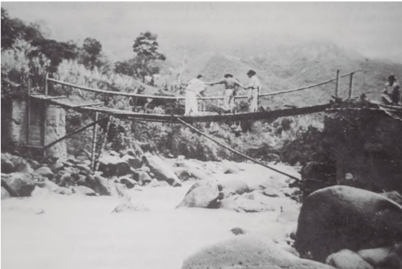
Los puentes, caminos y carreteras construidos a comienzos del siglo xx son el resultado del trabajo de las comunidades reunidas en convites. Puente colgante de guadua sobre el río Las Estancias, 1945. Fotografía tomada de Resguardo indígena de San Lorenzo, 2003, p. 152.
