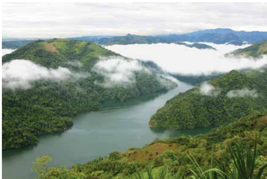
Represa – hidroeléctrica en el río La Miel en Norcasia. Fotografía: Juan Alberto Gómez Duque, CNMH-DAV, 2017.
